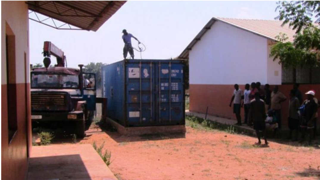
Il container riciclato come magazzino
