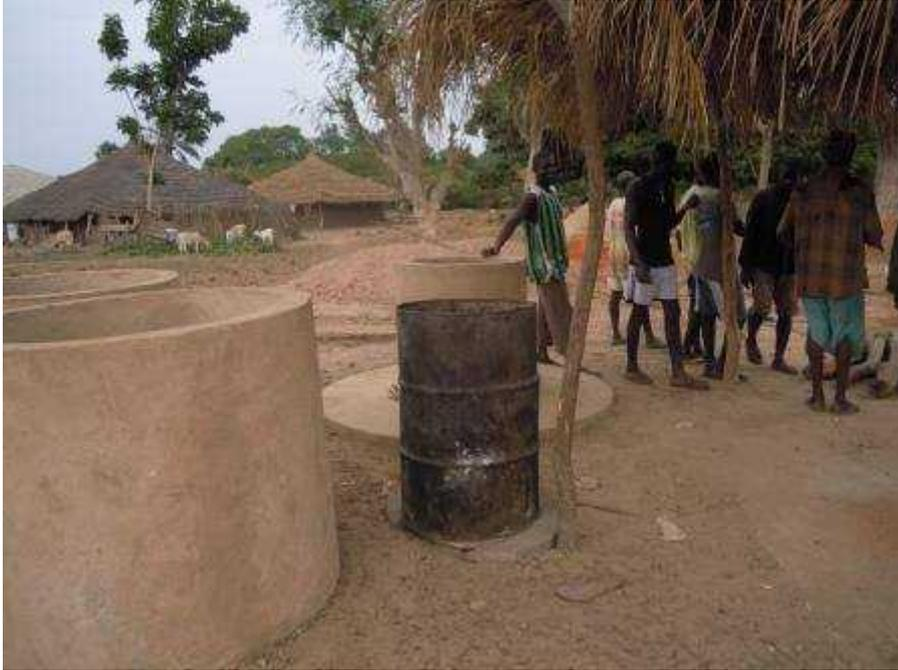
Ecco il pozzo vero e proprio. Adesso sono a 13 metri e vedete i cilindri di cemento ben posizionati. Si vede anche l'acqua giù, ma deve essere ancora scavato per andare più in profondità. Manca per ora la pompa che tira l'acqua fuori e permette di continuare a scavare. Bellissima la scaletta. Quando si lavora al pozzo un uomo sta giù con la pala e riempie un secchio gli altri sopra aspettano che il secchio sia riempito per tirare fuori la sabbia. Tutto scavato a "MANO!"
