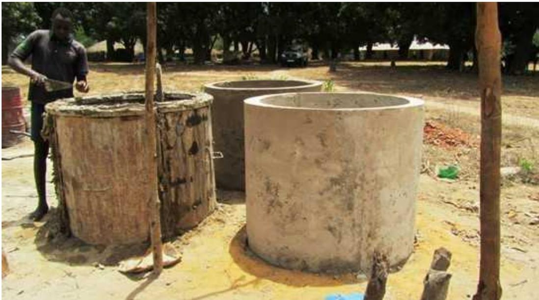
"Il pozzo è già fondo 11 metri. Sul fondo si trova già la prima acqua. La foto è quello che è..... Che volete, io non sono nato fotografo! Occorre continuare gli scavi per alcuni altri metri, così che vi sia acqua abbondante per tutti. Però guardate bene: tutto il pozzo è rivestito all'interno di anelli di cemento. Importantissimi! Così l'acqua rimane più pulita e diminuiscono le infezioni che l'acqua non pulita potrebbe causare tra le persone del villaggio."
